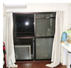
北側洋室引違い窓
