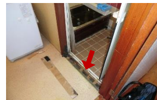
浴室出入口ドアまわり (入口の床をはがすとシロアリによって下地がボロボロに...)
