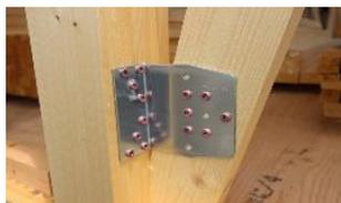
柱・梁・筋かいなどの接合部を金具で補強します。しっかり固定することで住宅の倒壊を防ぎます。
