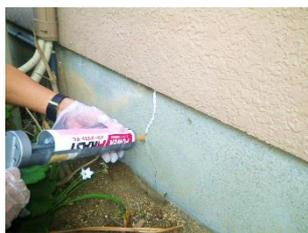
建物を支える基礎がしっかりしていなければ、地震に耐えることはできません。ひび割れを補修することにより現状の基礎の強度を維持させ、コンクリートの劣化を抑止します。
