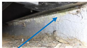
防水層が剥がれ、下地が出てしまっている
