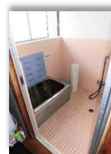
before タイル張り浴室
